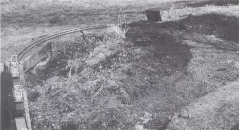
Während rechts die Dachpappe und der Schotter noch fehlen, sind links im Bild bereits die Geleise verlegt.
